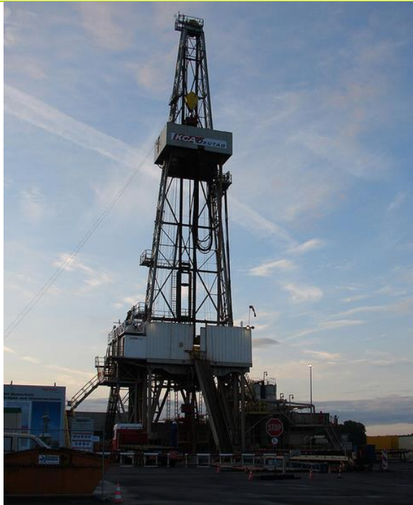
Abbildung 57: Bohrturm für tiefe und mitteltiefe Geothermie; Quelle: Bundesverband Geothermie 28
