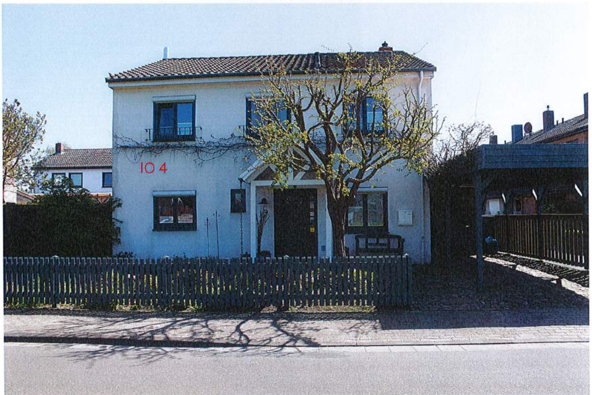
Bild 4: Immissionsort 4, Wohnhaus Kirchstraße 15
